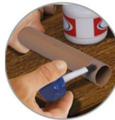
Aplique o adesivo na bolsa do Registro e, após, no tubo e encaixe os dois dando um giro de 1/4 de volta para uniformizar o adesivo na junta. Remova o excesso de adesivo.
